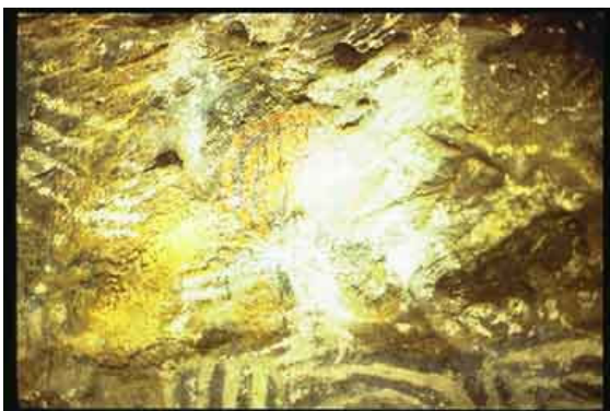
Fig. 25: Toca dos Búzios, antes de aplicação de compressa
