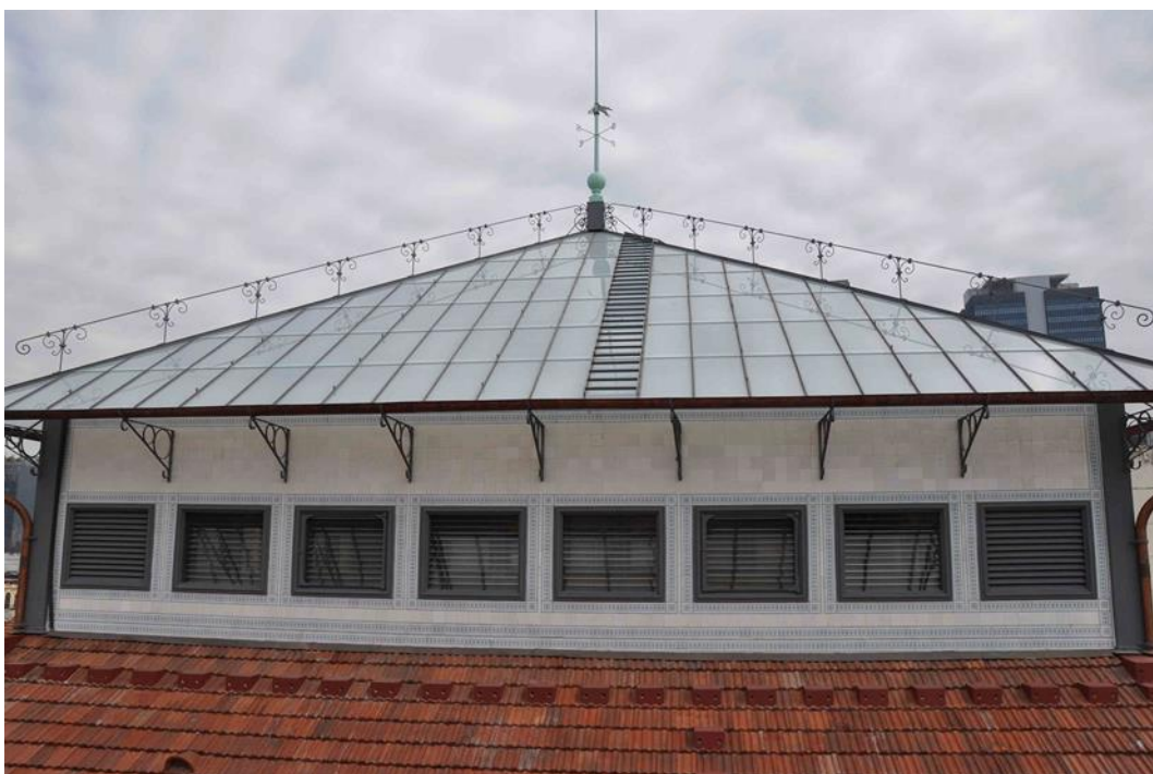
Figura 4 - Passadiço metálico sobre a claraboia 1 para a facilidade de manutenção da mesma (Autora: Clarissa Senna)
