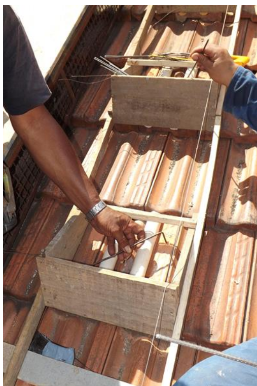
Figuras 8 e 9 - Sistema de ancoragem dos passadiços nas telhas, e exemplo da interligação entre os telhados promovida em toda a cobertura (Autora: Clarissa Senna)
