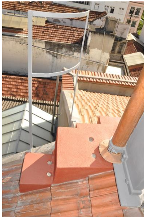
Figuras 10 e 11 - Instalação de escada metálica facilitando a passagens dos variados níveis dos telhados, e guarda-corpo metálico promovendo melhor acesso a locais de alta periculosidade (Autora: Clarissa Senna)
