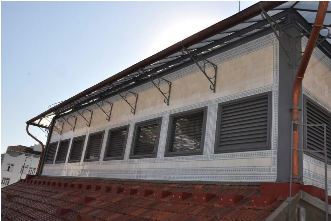
Figura 5 - Novas calhas em cobre reproduzidas com as mesmas características das originais (Autora: Clarissa Senna)
