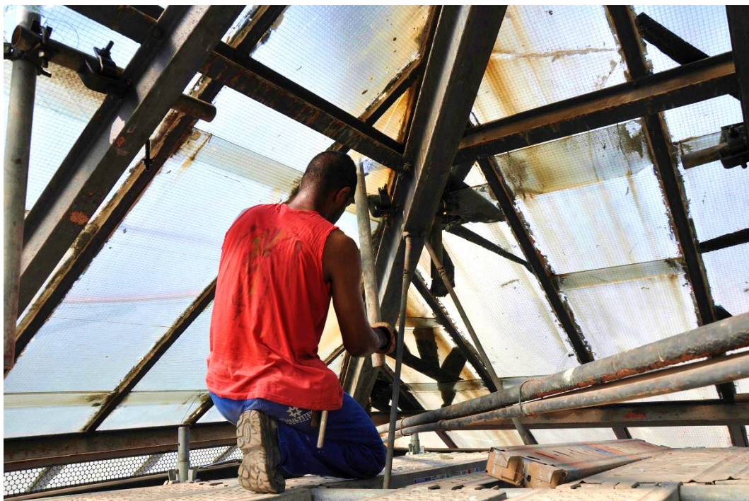
Figura 1 - Claraboia 1 em seu estado de degradação inicial (Autora: Clarissa Senna)
