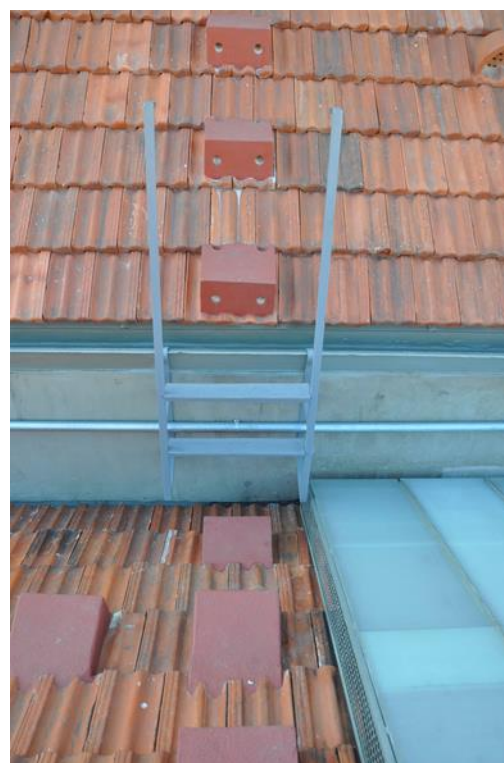
Figuras 8 e 9 - Sistema de ancoragem dos passadiços nas telhas, e exemplo da interligação entre os telhados promovida em toda a cobertura (Autora: Clarissa Senna)
