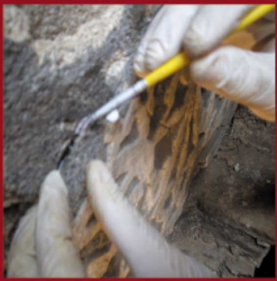
Consolidação do substrato cinza com resina polivinica.
