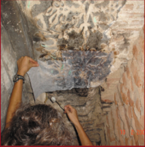
Início do faceamento executado pela restauradora Márcia Braga com CMC e tecido de nome comercial Fisilina.
