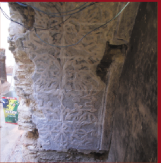
Vista do arco com faceamento, inclusive no friso lateral.
