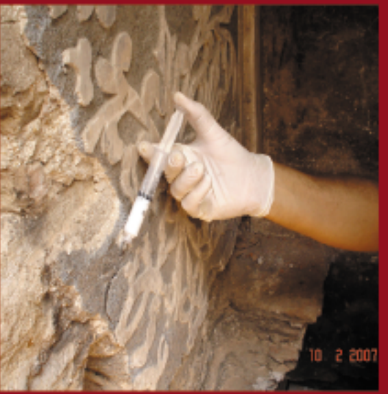
Consolidação do substrato cinza com resina polivinica.
