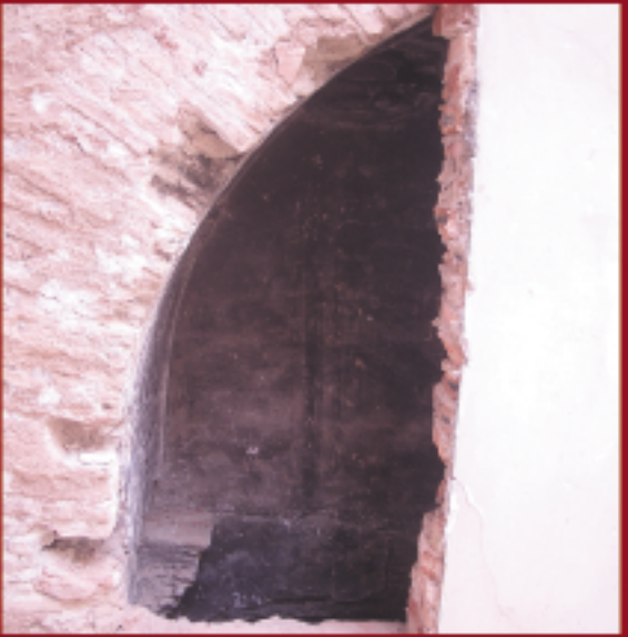
Vista frontal do arco após a demolição parcial da parede do segundo pavimento.
