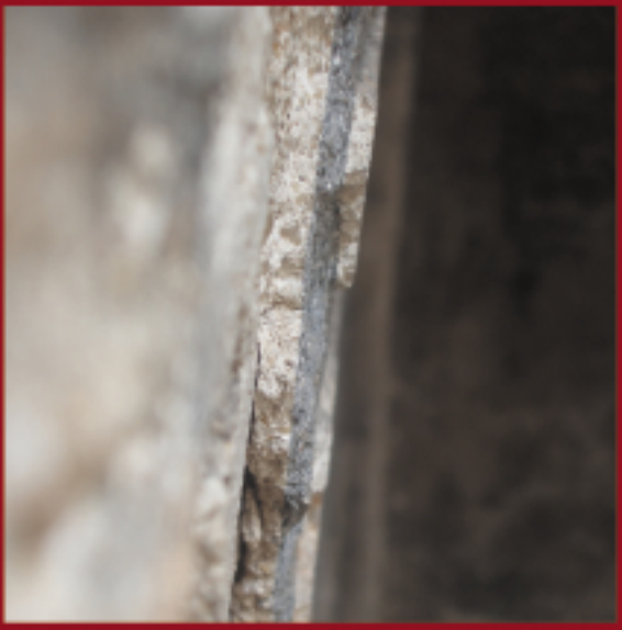
Vista de da estratigrafia das argamassas, a esquerda argamassa de nivelamento no meio (cinza), argamassa de base; a direita (branca) argamassa decorativa fitomorfa.
