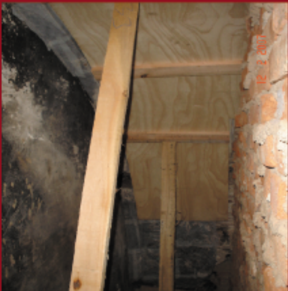
Vista do escoramento com proteção prévia de espuma.
