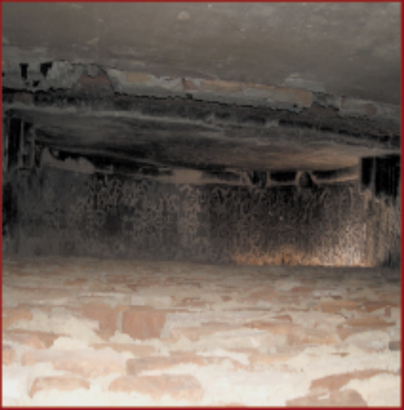
Vista do arco com o emparedamento.
