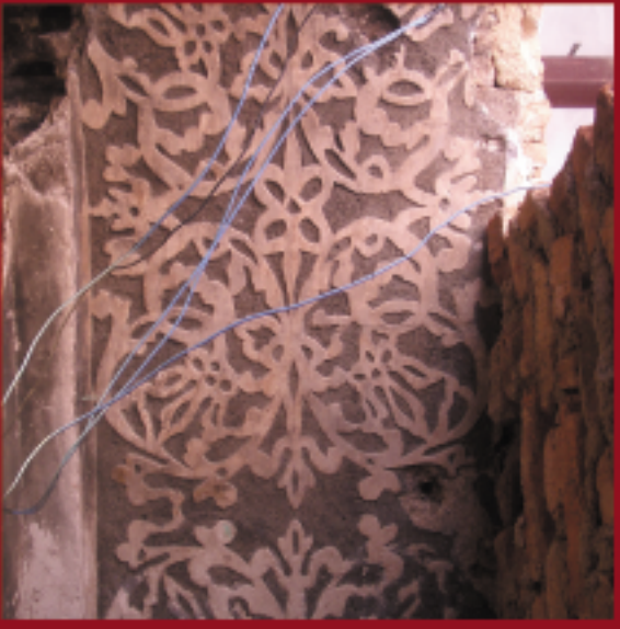
Vista do esgrafito após a limpeza mecânica.
