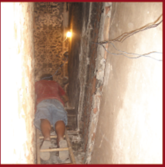
Restaurador Marco Polo aplicando a resina Paraloid B72 para consolidação superficial.
