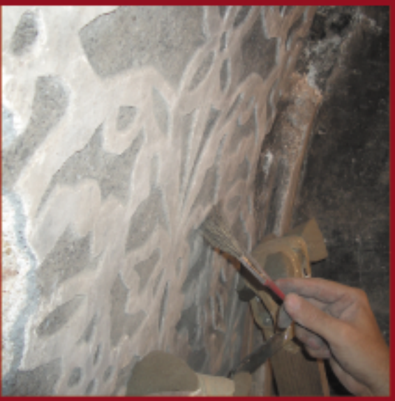
Limpeza mecânica com trincha para remoção de fuligem e poeira.
