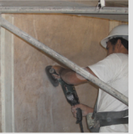
Nivelamento de rachadura executado com fixadeira mecânica, após consolidação interna.
