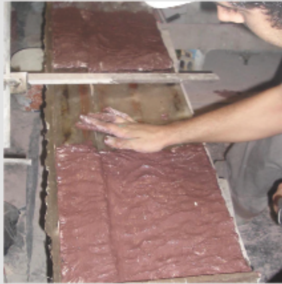
Aplicação da argamassa da escaiola sobre molde em poliéster para recomposição das bases das colunas.
