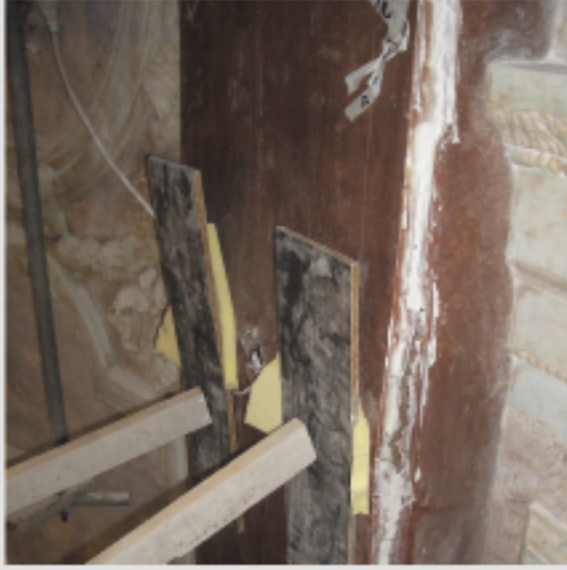
Consolidação de rachaduras (vertical e horizontal) através de gotejamento (no alto à esquerda), seguido de tamponamento com proteção de espuma.
