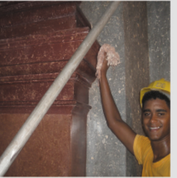
Aspecto final, após polimento com cera micro cristalina.
