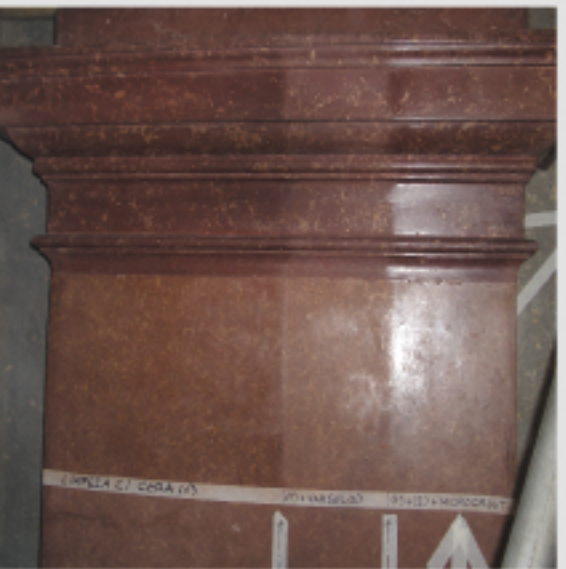
Sequência dos trabalhos executados nas colunas e lesenas: a esquerda, após a remoção da cera avermelhada através de esfregaços de cera micro abrasiva; no centro, remoção do excesso da cera micro abrasiva com varsol; na direita, após aplicação de cera micro cristalina para acabamento final.
