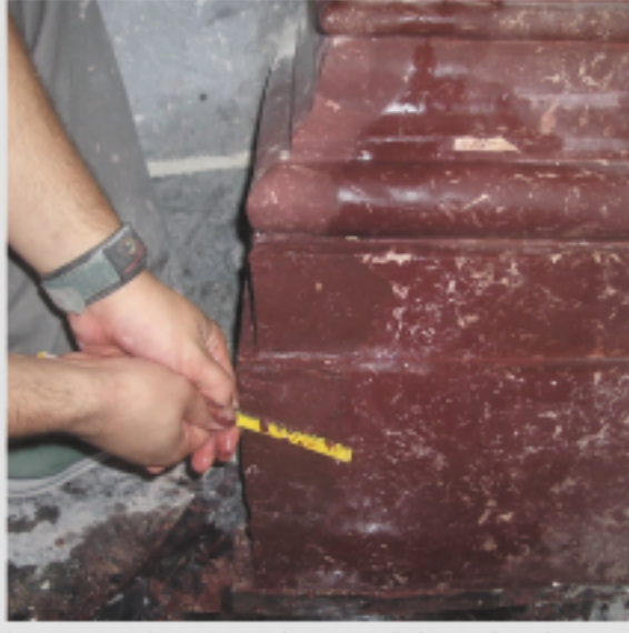
Lixamento da prótese da quina da base da coluna e de todos os frisos.
