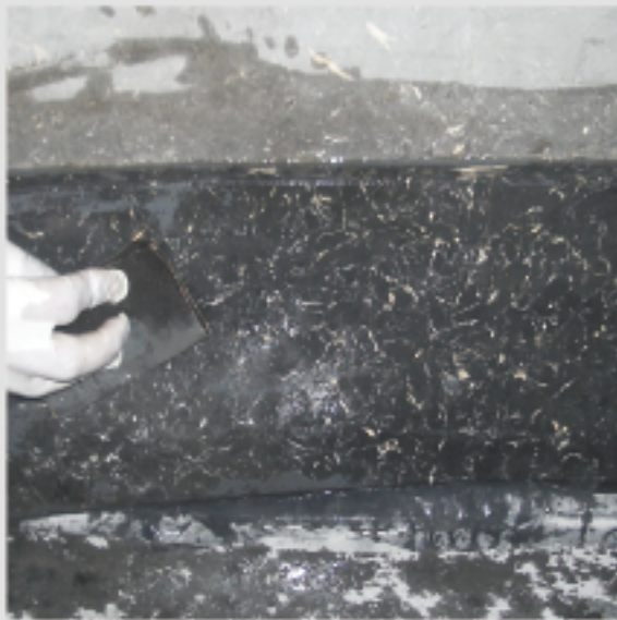
Lixamento manual do rodapé que se encontrava pintado com tinta PVA azul escura.
