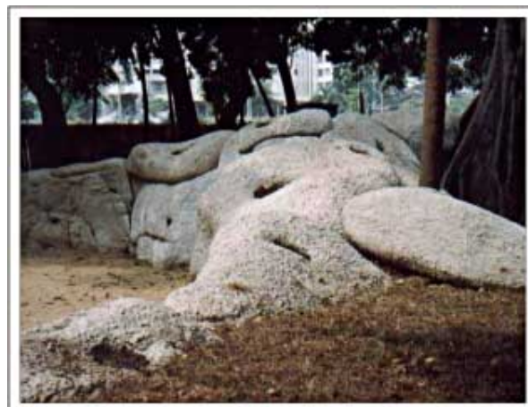
As rocailles de argamassa instaladas na reforma Glaziou já estão recuperadas
