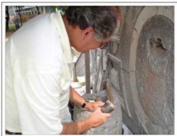
O restaurador Emílio Gianelli está recuperando os trabalhos de cantaria da Fonte dos Amores
