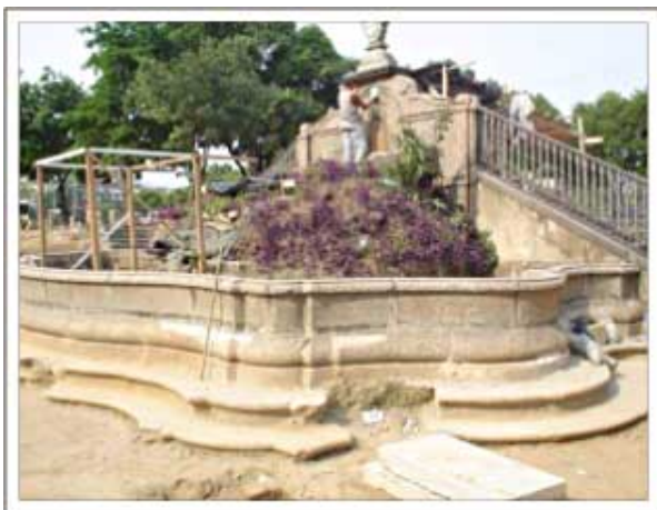
O conjunto da Fonte dos Amores está sendo todo restaurado
