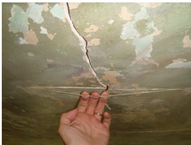
Fig. 11 - Teste para remoção dos fios de nylon
