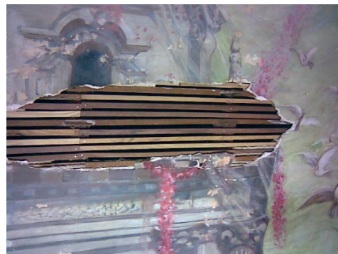
À esquerda (fig. 6), vista do entre forro consolidado e à direita (fig. 7), vista dos fasquios novos na perda inferior
